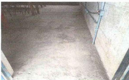
Foto 3: Sustitucion de piso de torta de cemento
